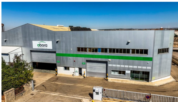
Instalaciones de Abora Solar
