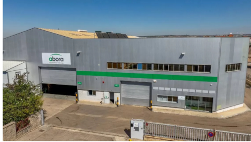
Instalaciones de Abora Solar en Zaragoza.
