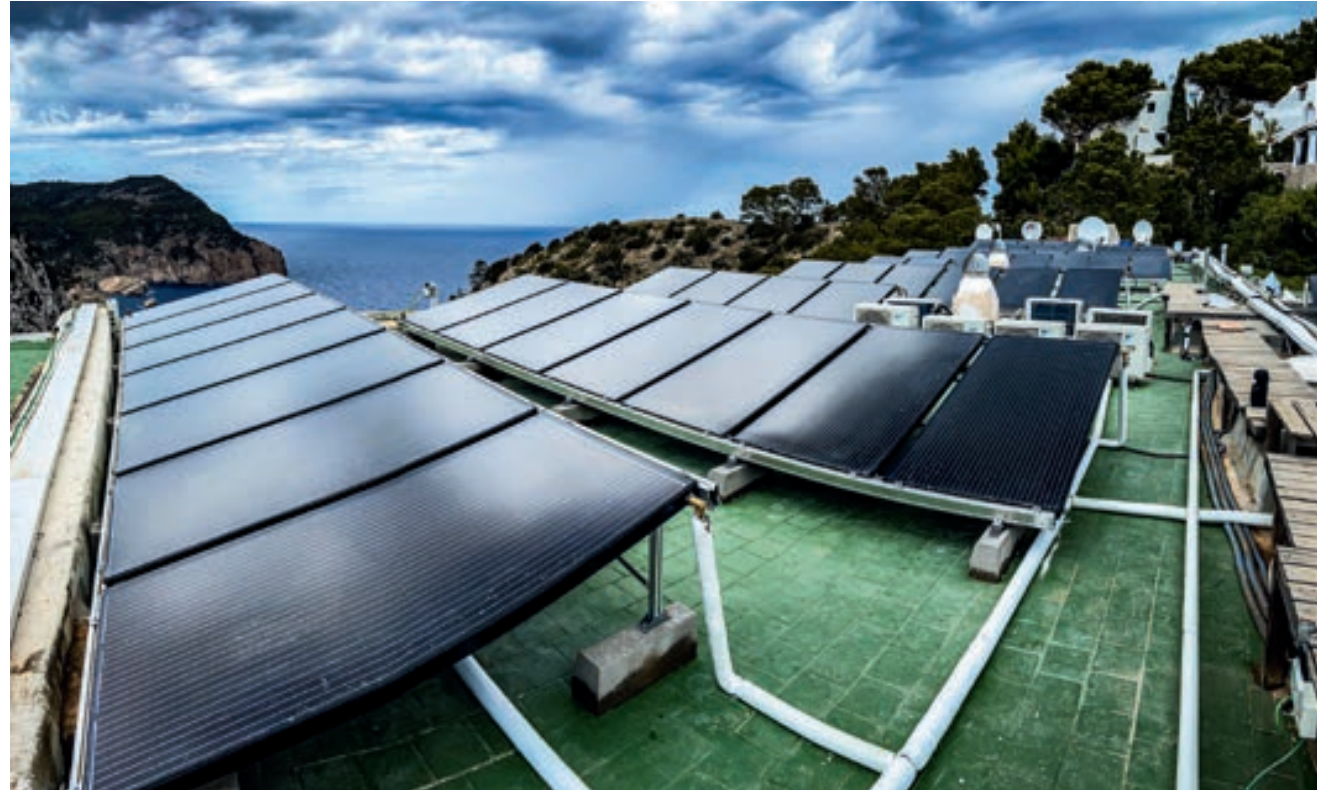
Ibiza- Instalación de paneles solares híbridos en el hotel Na Xamena
