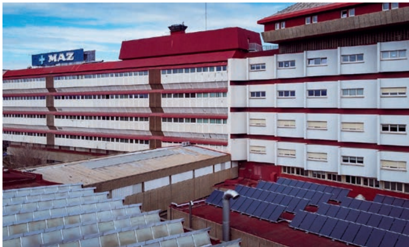
Saragosse - Installation de panneaux solaires hybrides à l'hôpital La Maz
