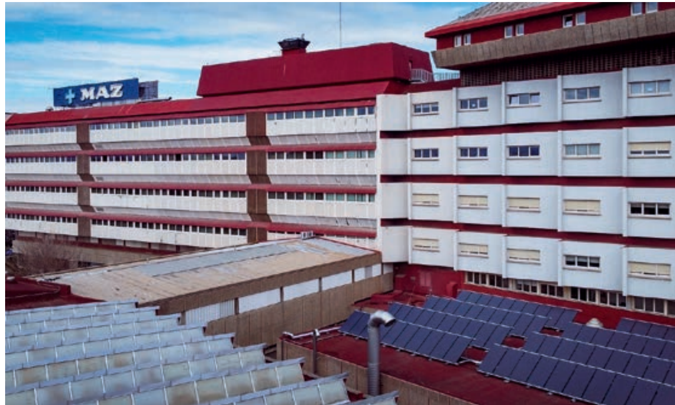
Zaragoza - Installation von Hybrid-Solarzellen im Krankenhaus La Maz
