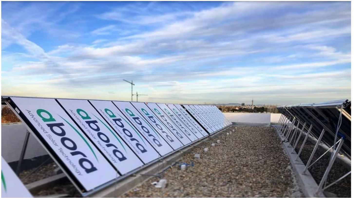
Instalación de paneles solares híbridos de la empresa española Abora Solar. / ABORA SOLAR
